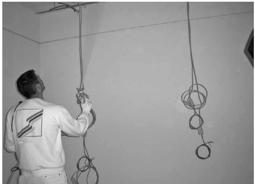
Abbildung E.18: Spritzputz im Deckenbereich aufbringen
