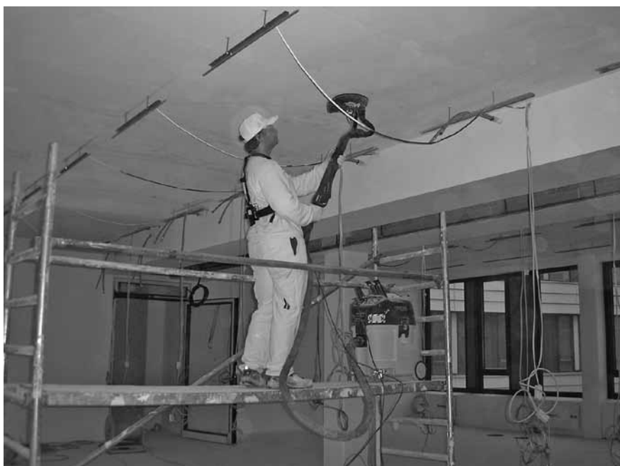
Abbildung E.19: Schleifarbeiten im Deckenbereich
