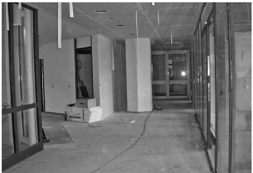
Abbildung E.7: Baustelle 7
