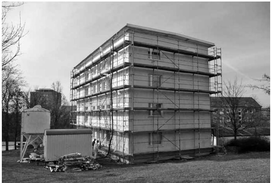
Abbildung E.11: Baustelle 11
