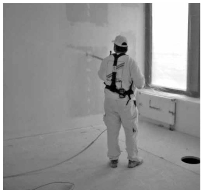
Abbildung E.16: Farbauftrag mit Airlessgerät
