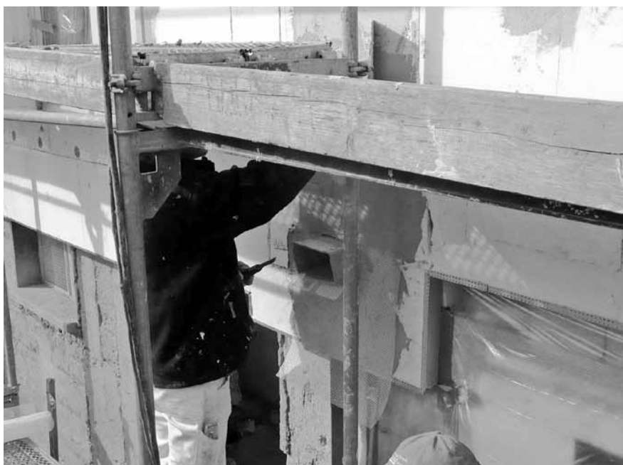
Abbildung E.36: Armierungsgewebe anbringen
