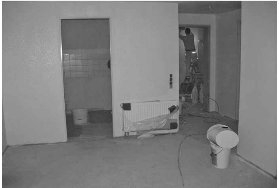
Abbildung E.10: Baustelle 10
