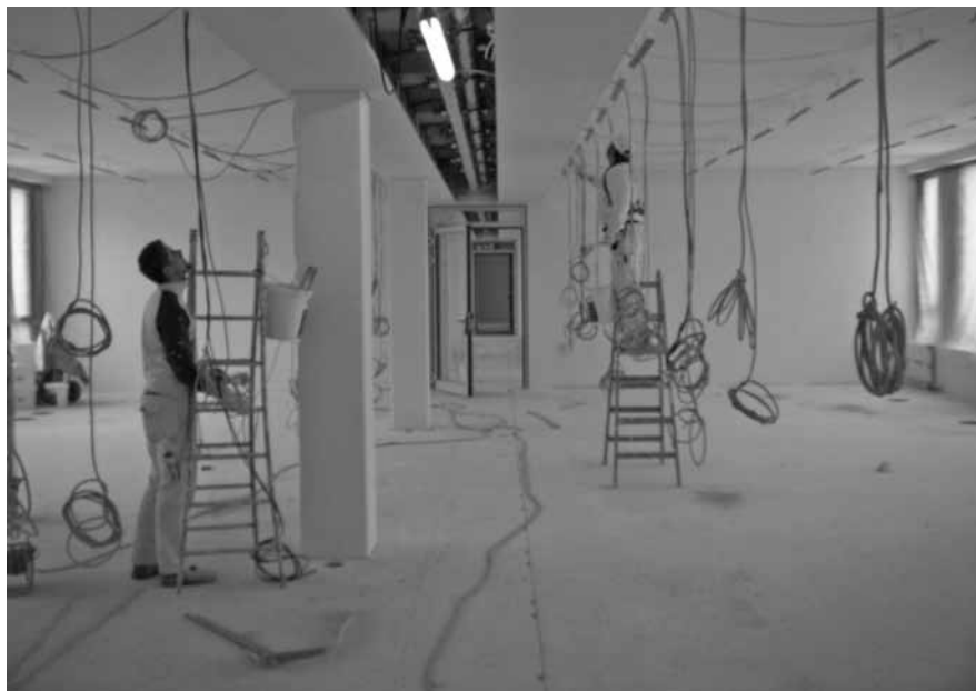
Abbildung E.3: Baustelle 3
