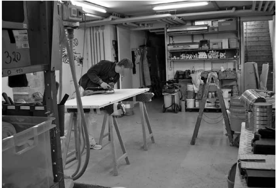
Abbildung E.5: Baustelle 5
