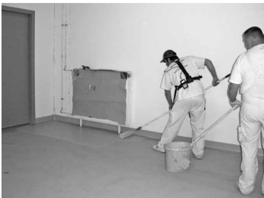
Abbildung E.30: Fußbodenbeschichtung mit der Rolle
