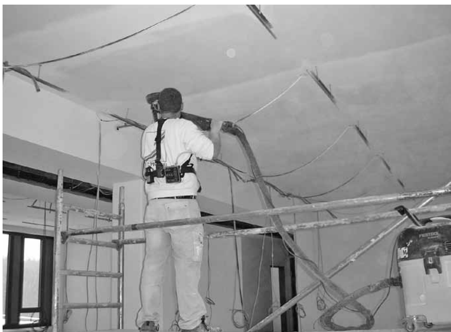
Abbildung E.22: Schleifarbeiten im Deckenbereich
