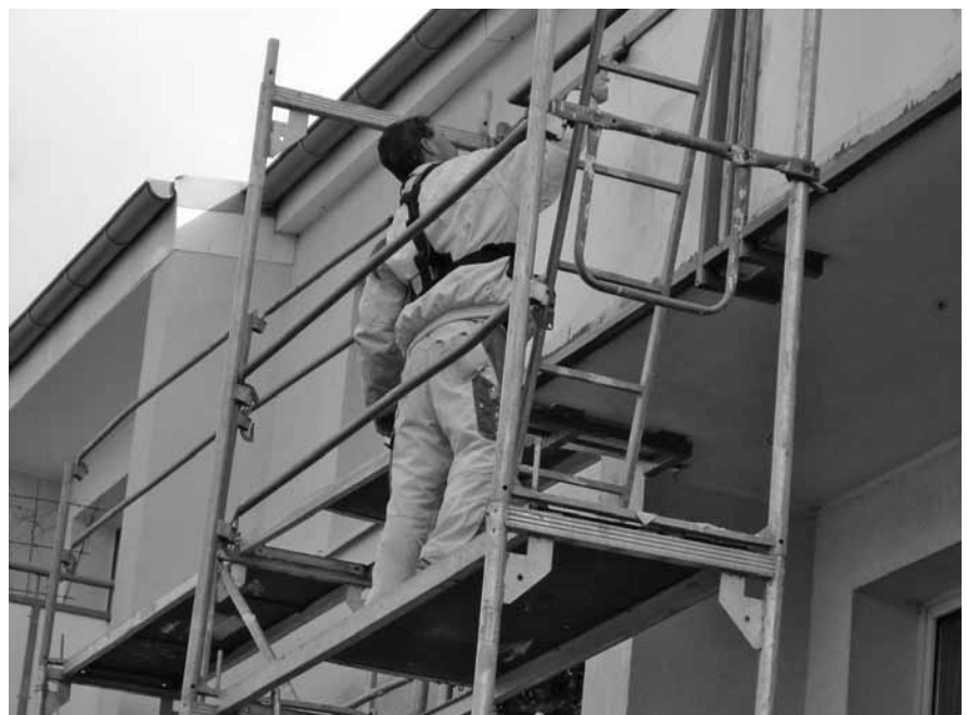
Abbildung E.13: Fassade streichen
