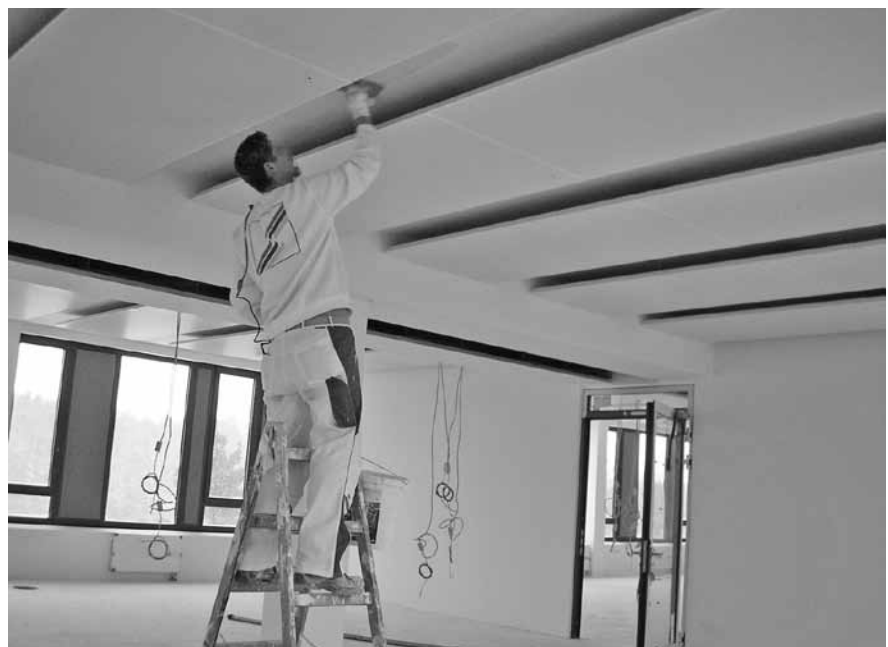
Abbildung E.21: Deckenoberfläche spachteln
