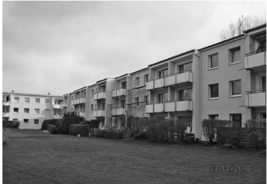
Abbildung E.1: Baustelle 1
