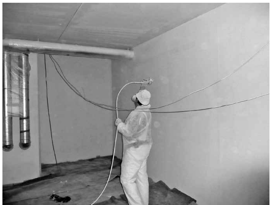
Abbildung E.25: Decke im Airlessverfahren lackieren
