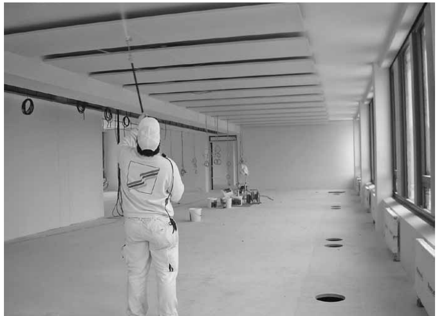
Abbildung E.23: Dispersionsfarbe im Deckenbereich aufbringen
