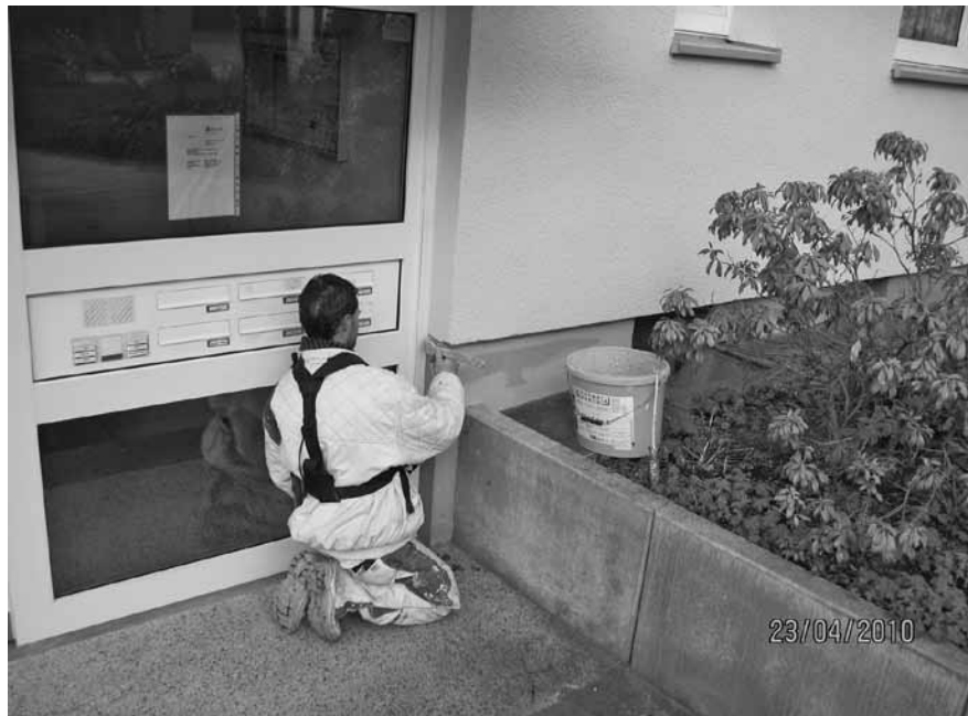
Abbildung E.14: Fassadensockel streichen
