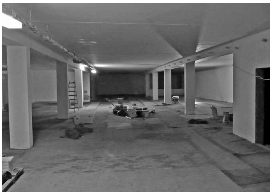
Abbildung E.4: Baustelle 4
