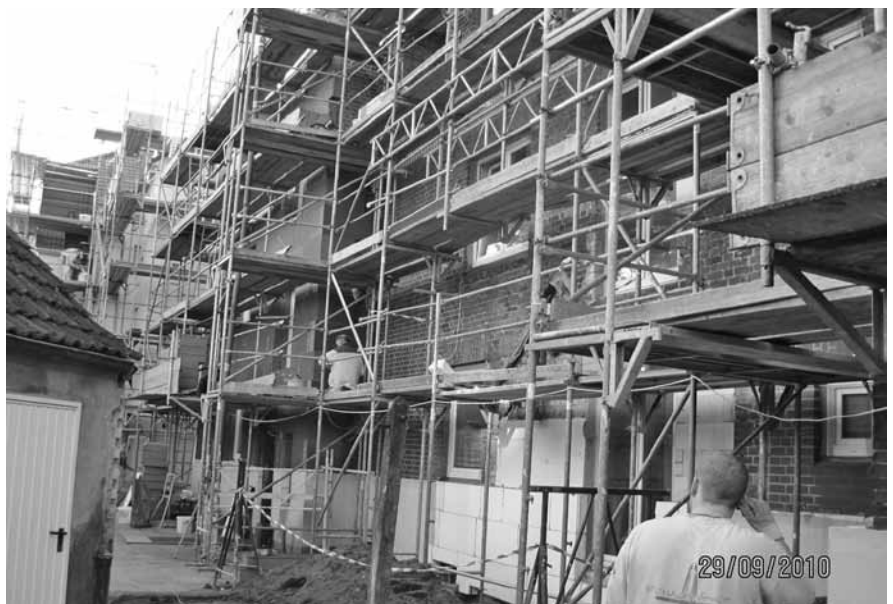
Abbildung E.12: Baustelle 12
