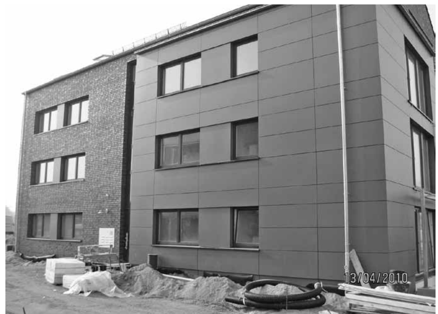
Abbildung E.2: Baustelle 2
