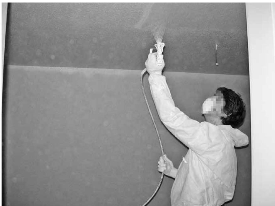
Abbildung E.34: Spritzen von Dispersionsfarbe mit Airless-Spritzsystem
