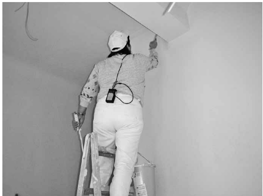
Abbildung E.33: Dispersionsanstriche mit dem Pinsel auftragen
