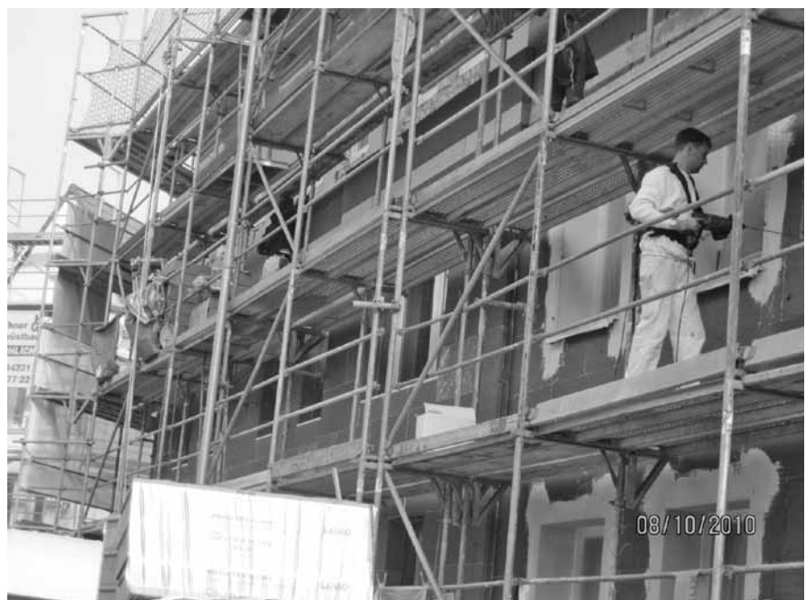
Abbildung E.37: Ankerlöcher bohren
