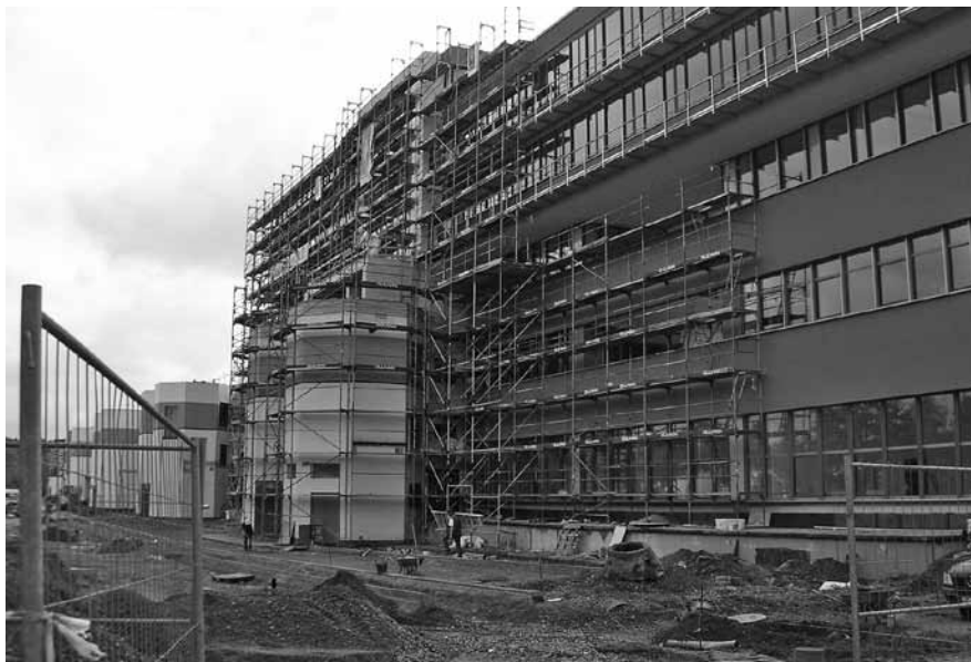
Abbildung E.8: Baustelle 8
