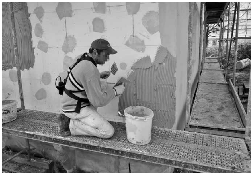
Abbildung E.35: Armierungsmörtel auftragen
