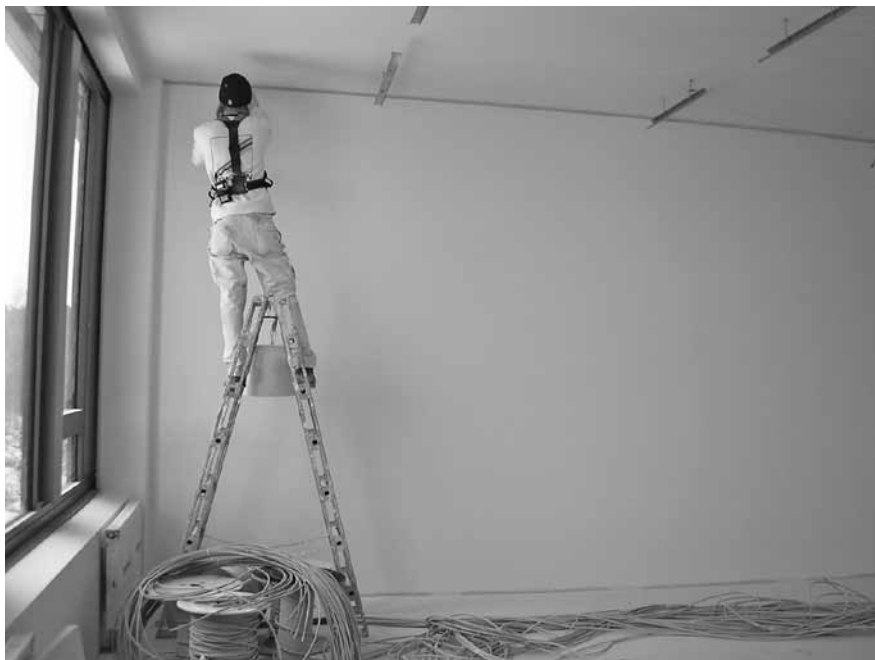
Abbildung E.24: Anstricharbeiten mit Pinsel und Rolle
