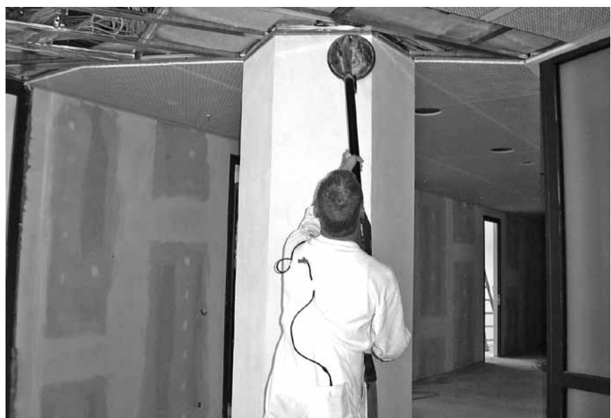
Abbildung E.29: Spachtelmasse abschleifen
