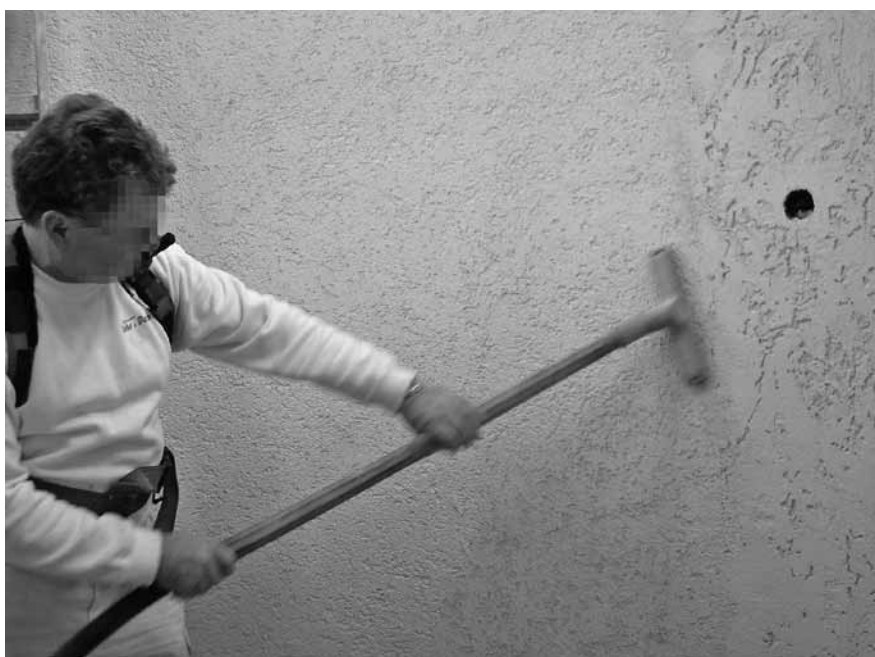
Abbildung E.32: Wand im Treppenhaus absaugen
