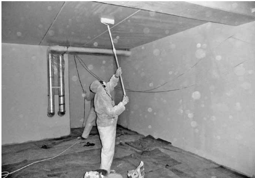
Abbildung E.26: Arbeiten mit der Rolle
