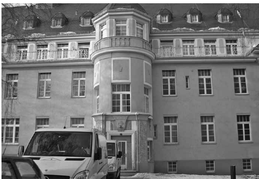
Abbildung E.9: Baustelle 9
