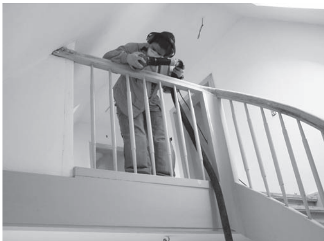
Abbildung B.23: Handlauf mit einem Winkelschleifer abschleifen
