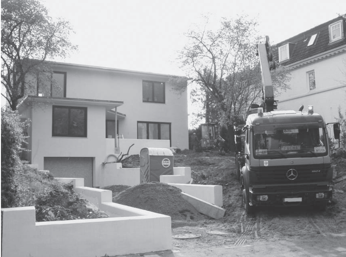
Abbildung B.5: Baustelle 7
