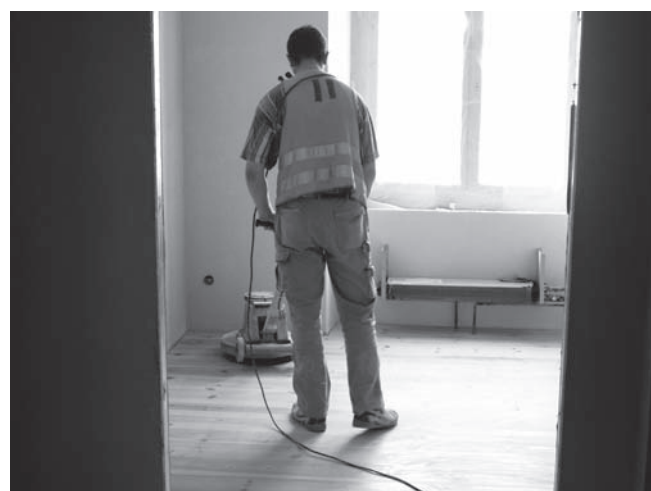
Abbildung B.15: Geöltes Parkett mit Einscheibengerät polieren
