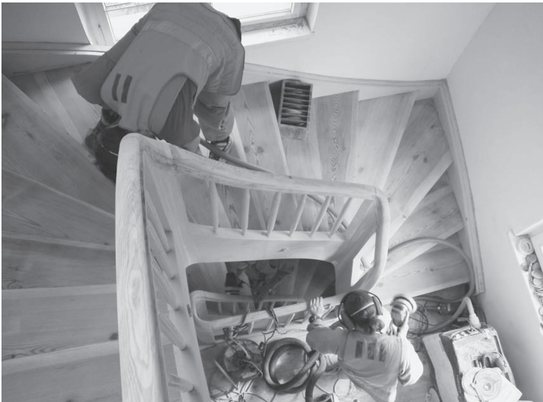
Abbildung B.6: Baustelle 9
