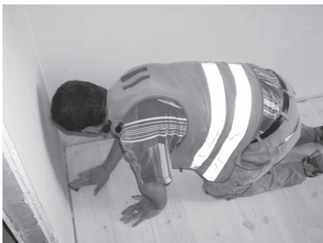
Abbildung B.16: Parkett mit Schleifpapier abschleifen
