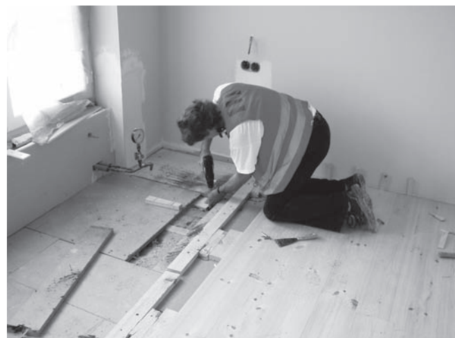
Abbildung B.17: Unterbau mit Schrauben befestigen
