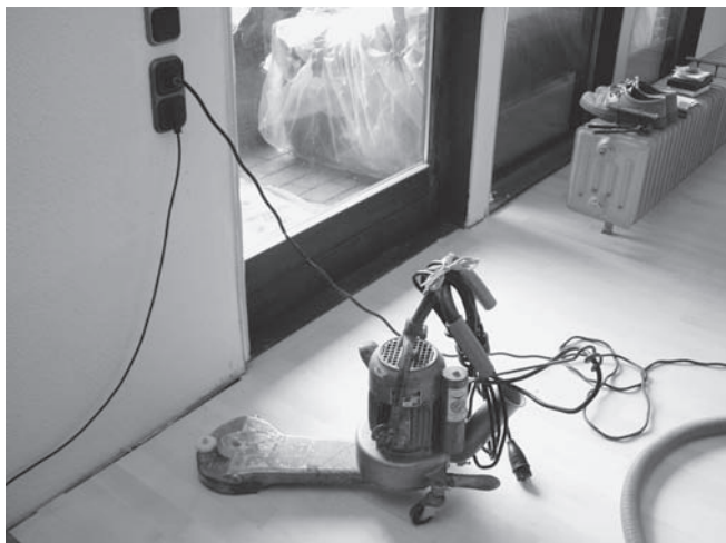
Abbildung B.8: Parkett mit handgeführtem Gerät abschleifen
