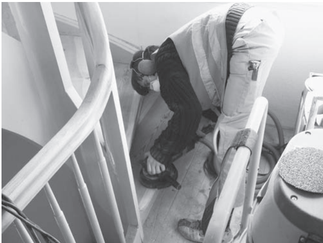
Abbildung B.25: Abschleifen der Treppenstufen mit einem Winkelschleifer
