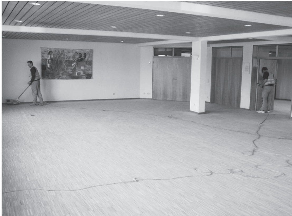
Abbildung B.4: Baustelle 6
