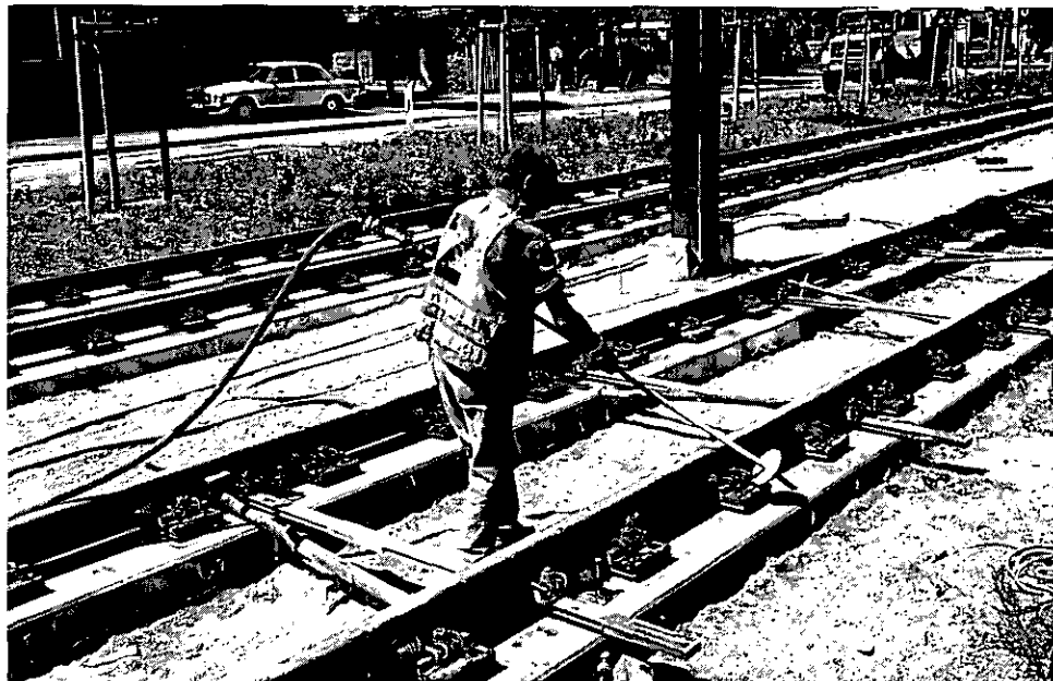
Abbildung 9: Bohlöcher mit Druckluft säubern (A 26)
