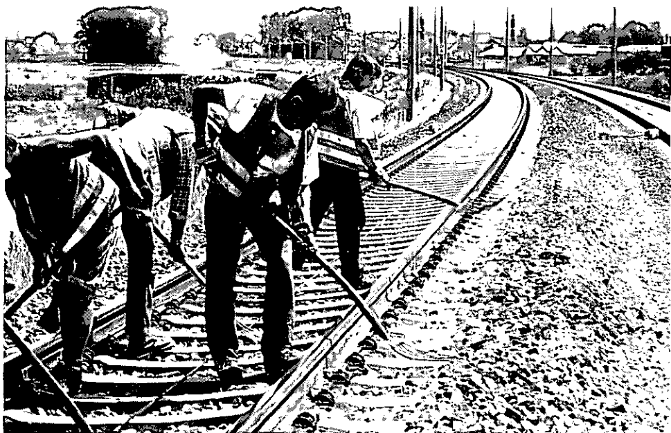
Abbildung 12: Arbeit mit der Schottergabel (A 36, A 37, A 38)
