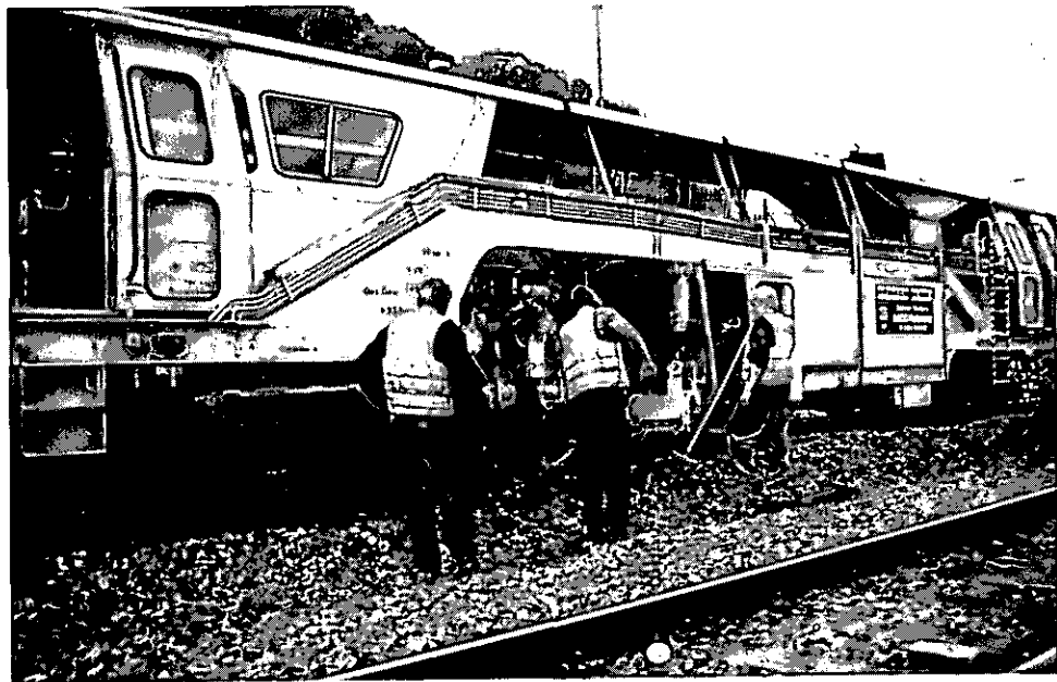
Abbildung 6: Arbeit mit der Schottergabel in der Nähe der Gleisstopfmaschine (A 20, A 21, A 22)
