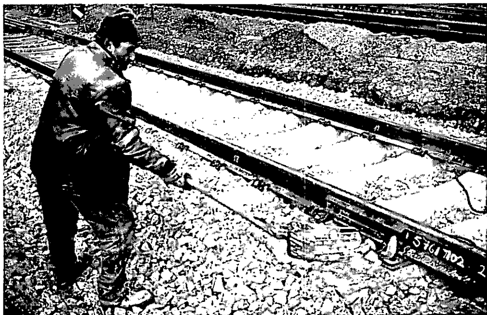
Abbildung 2: Schotter mit der Handgabel verteilen (A 2)
