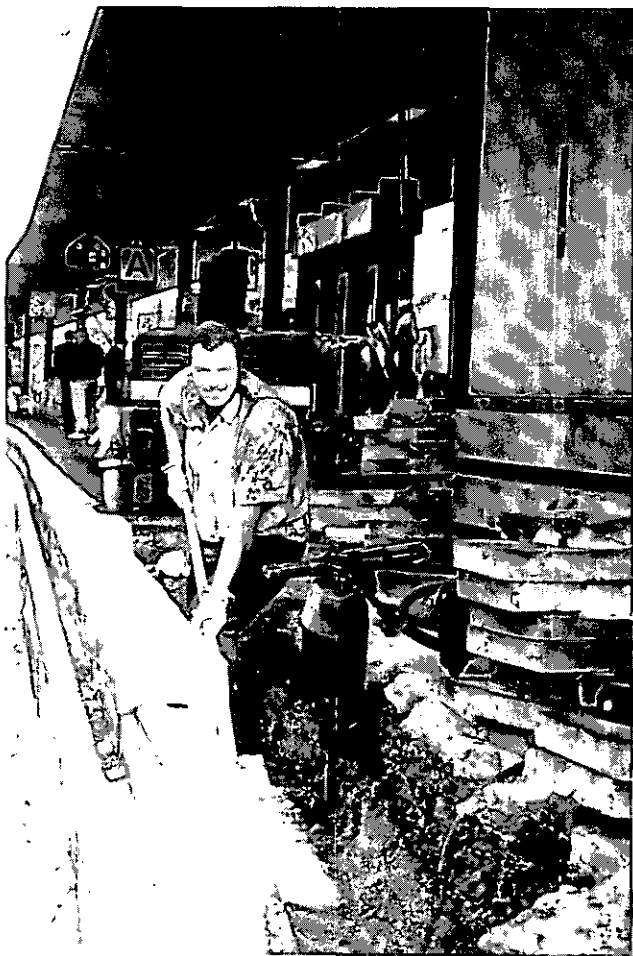
Abbildung 16: Bahnsteigkante mit Druckluft- hammer entfernen (A 47)
