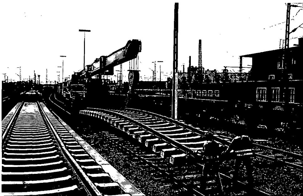
Abbildung 5: Hilfe bei Gleisjochtransport mit Kran (A 16 und A 17)
