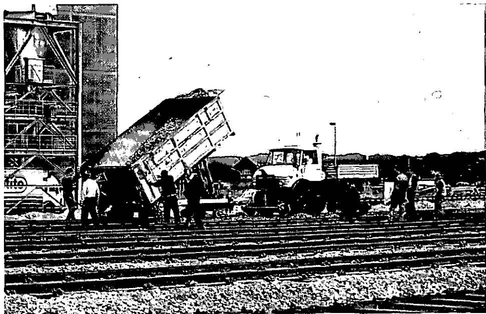
Abbildung 14: Schotter ins Gleis füllen (A 42, A 43, A 44)
