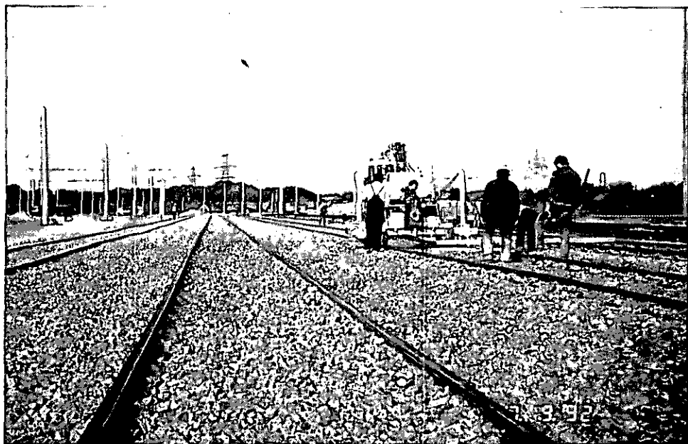
Abbildung 13: Gleise ausrichten und nivellieren (A 39, A 40, A 41)
