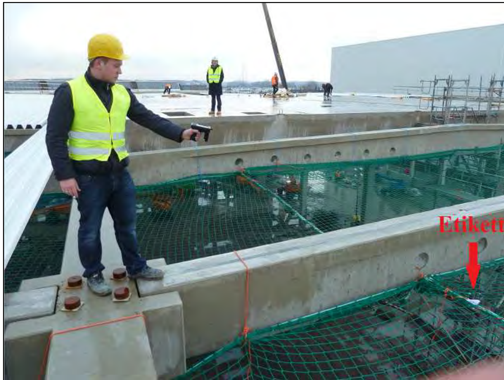
Abbildung 165: Kontrolle eines Etiketts mittels Handleser
