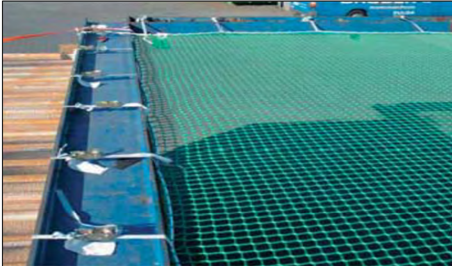
Abbildung 156: Befestigung eines Arbeitsplattformnetzes 100
